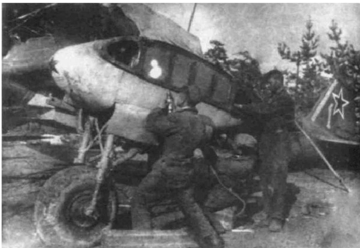
Механики 810-го ШАП ремонтируют самолет Андреева ИИ. после повреждений, полученных при налете на скопление немецких танков под Мценском В момент съемки они делают рассверловку под ленту, прикрывающую стык консоли с центропланом
